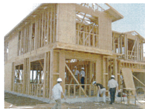
写真4 ハワイの全構造材ホウ酸塩処理住宅の建設現場
